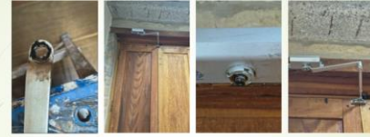
CAMBIO BRAZO HIDRAULICO OFICINA DPR BOTICA
